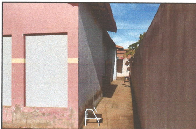
FIGURA 02 - Pintura externa danificada
